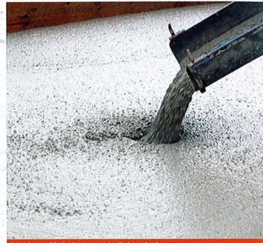
Direktes Einbringen mit Fahrmischer
