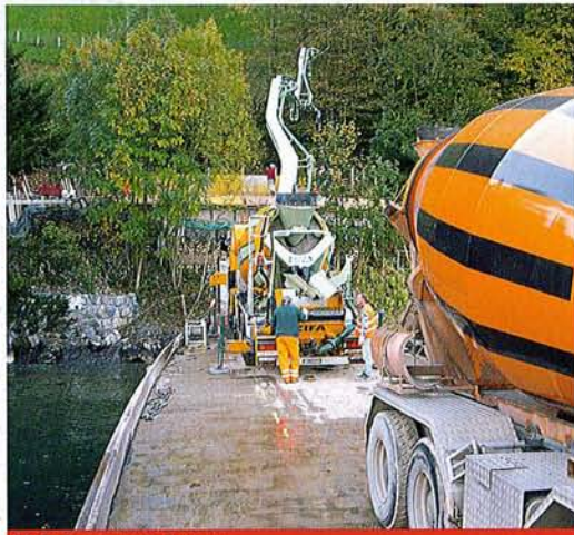
Einbringen mit Pumpe
