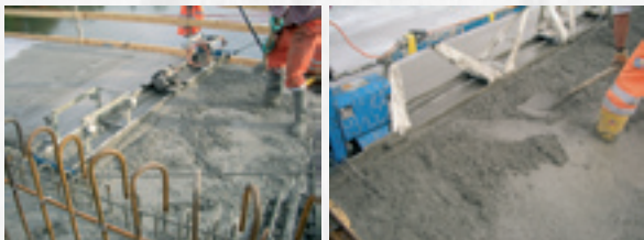
Vibrieren mit Abzugsbalken
